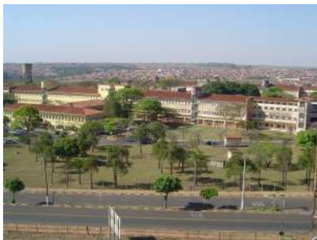
Hospital Emílio Carlos - Câmpus Sede das FIPA
